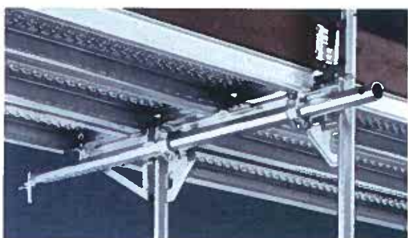
Dlouhé kotvy se speciální spojkou do rohového plechu
